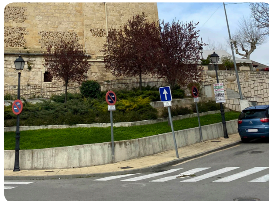
Acondicionamiento del entorno de la Iglesia de San Cipriano Fotografía actual
